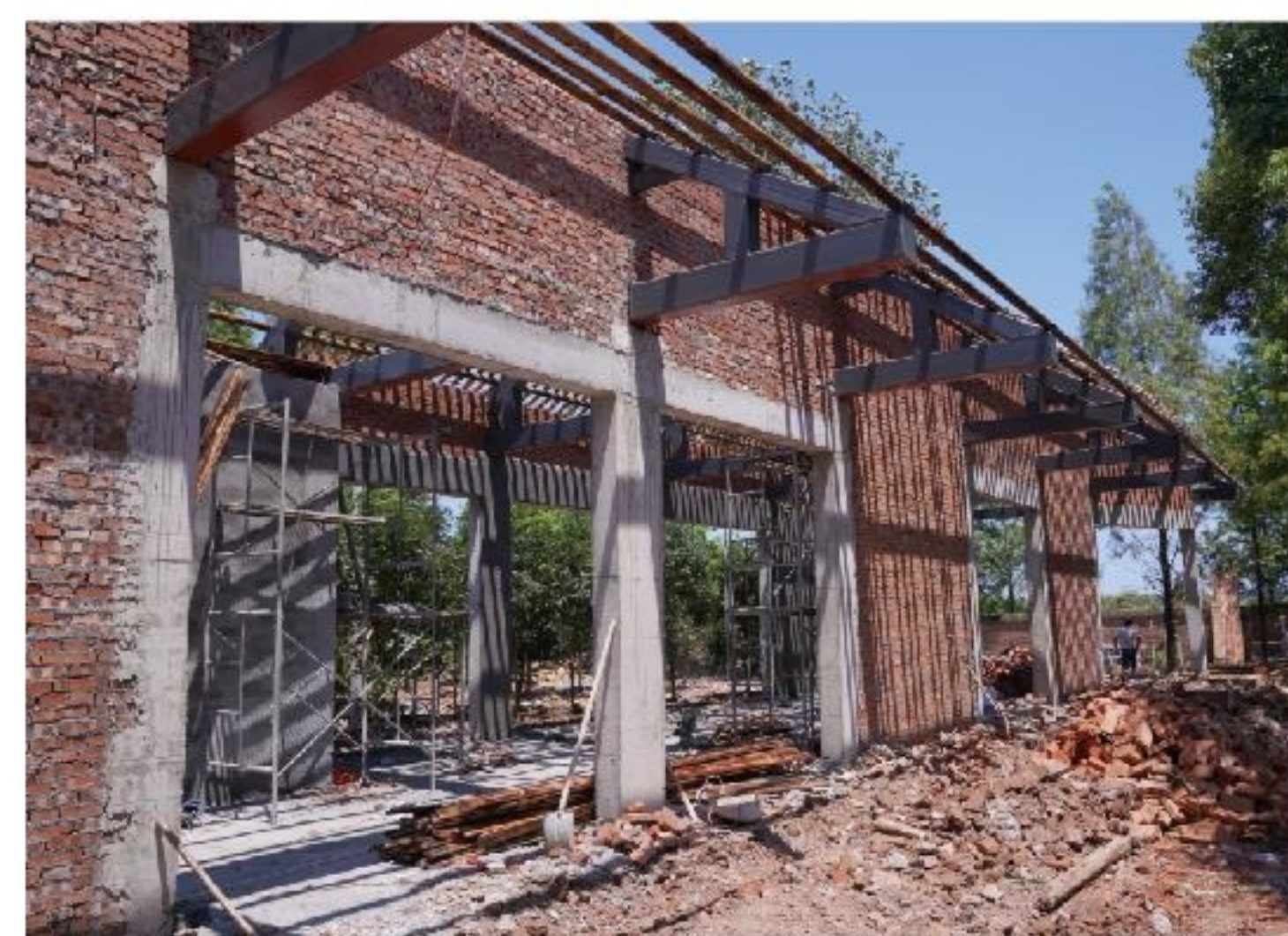
南县南山村乡村相见小院修建中
